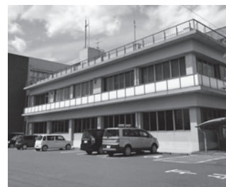
▲立田支所の解体部分
